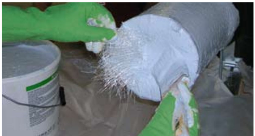
■ Foto 4: Bevochtiging van de glasvezelmat van Arma-Chek Web in de basisbekleding
