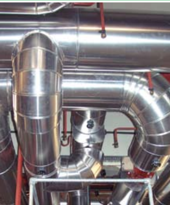
■ Foto 1: Ommanteling met Okabell van een deel van de installatie van de onderneming Ritter Sport in Waldenbuch
