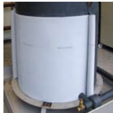
■ Foto 10: Bescherming van het oppervlak van een recipiënt met een ommanteling in EPDM-rubber tijdens de afwerkingsfase
