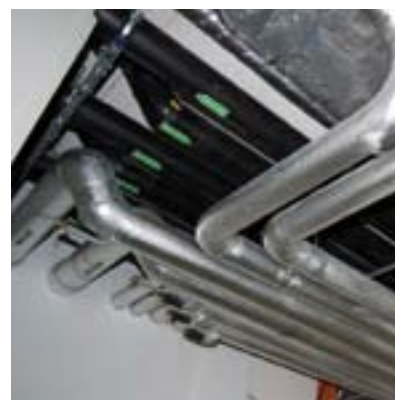
■ Foto 2: Ommantelingen in aluminium met grove korrel kunnen als extra dampscherm fungeren
