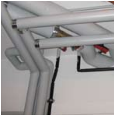
■ Foto 3: Ommantelingssystemen in pvc zijn geschikt voor binneninstallaties
