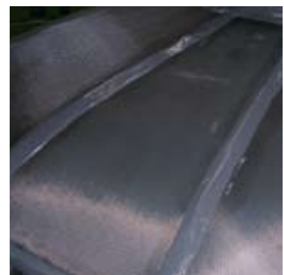
■ Foto 8: Door mastiek waterdicht gemaakte naden van een met een glasvezeltextuur ommantelde recipiënt
